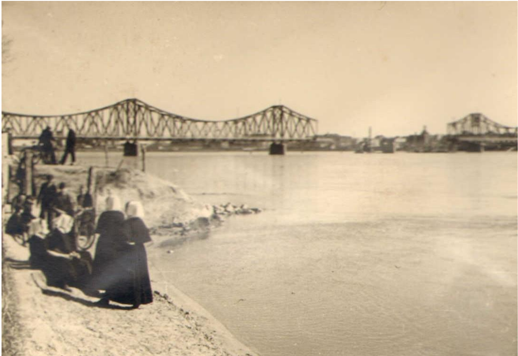
Widok z plaży nad Wisłą od strony Szpetala Dolnego na most stalowy im. Edwarda Rydza -Śmigłego oddany do użytku 25.09.1937r.; zniszczony przez wojsko polskie 09.09.1939r.; odbudowany przez Niemców w 1944r.; zniszczony przez wojska niemieckie w 1945 roku; odbudowany w 1948r. Zdjęcie pochodzi z prywatnych zbiorów Marka Grzesia.
