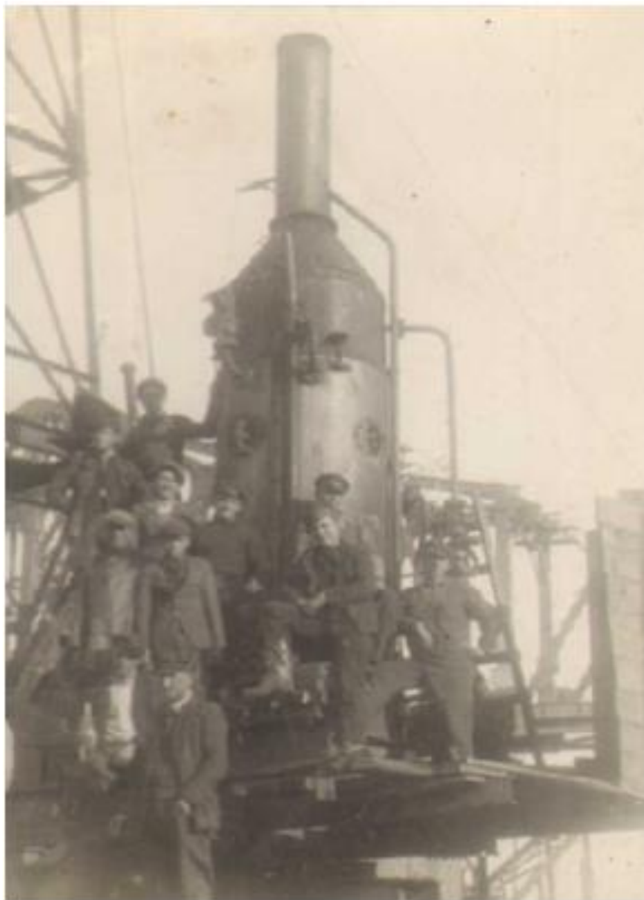
Kocioł parowy do kafara przy odbudowie mostu. (ze zbiorów Romana Kamińskiego)
