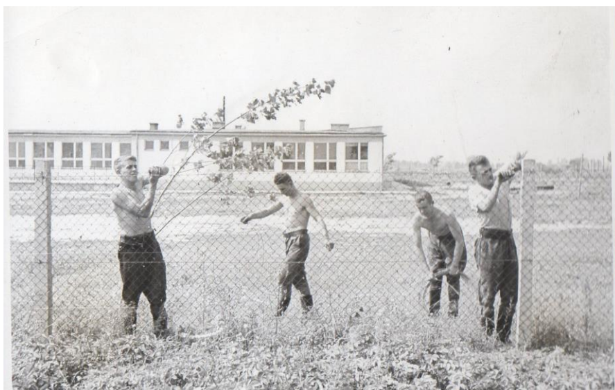
Żołnierze przy wykonywaniu ogrodzenia
